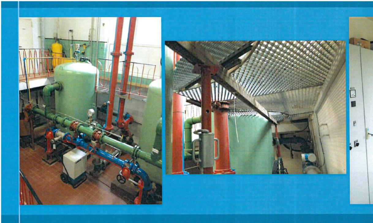
Abbildung 3: Filteranlage/ Druckfilter Wasserwerk Schaidt
